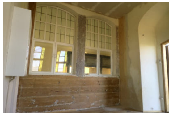
Trennwand zum Kirchenschiff Blick nach Süden
