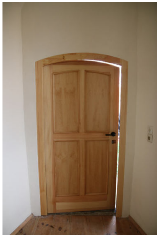
Neuanfertigung der Außentür: Blick aus der Prinzenloge in Richtung Treppenaufgang
