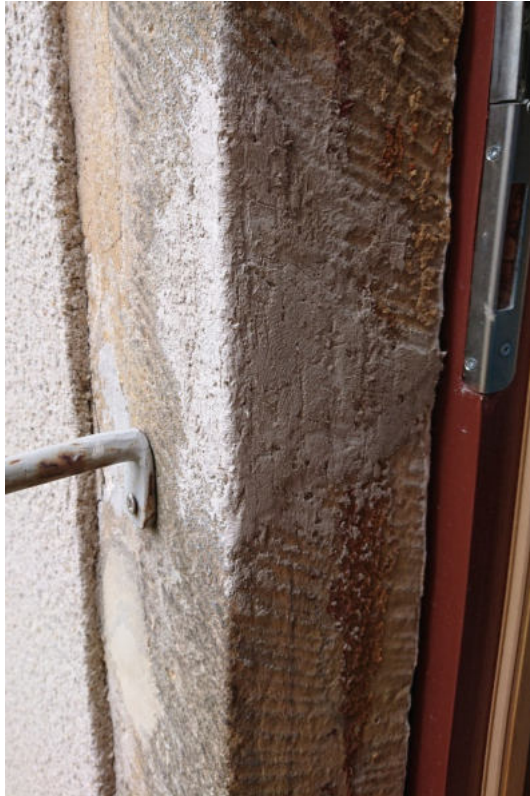
Alte Schlossfalle ausbauen + ausbessern
