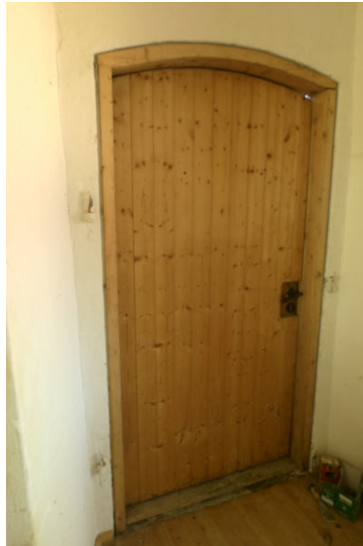
Außenholztür vor Sanierung
