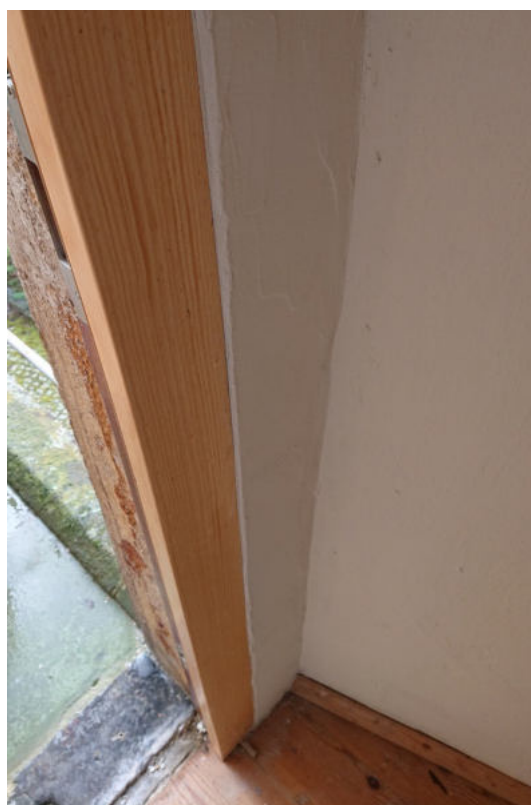
Putz angleichen am Türrahmen
