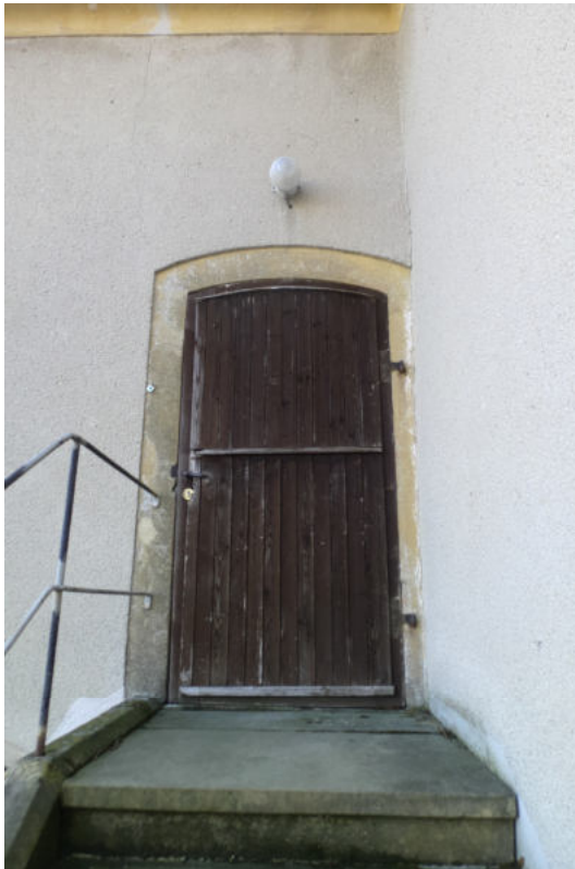
Blick auf die Prinzenloge / Treppenaufgang
