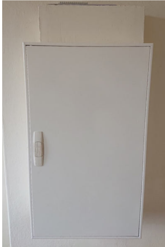
Verkleidung Sicherungskasten + Unterputzverlegung
